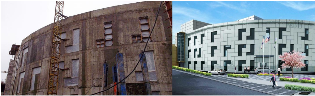
Rajah 11: Bangunan Kedutaan Malaysia di Rusia (Sumber: Akitek Suria, Malaysia).
